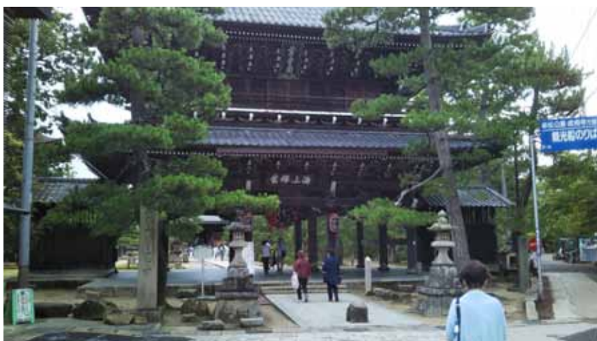
天橋立 知恩寺 山門
