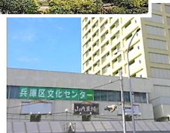
兵庫区 文化センター 体育館
