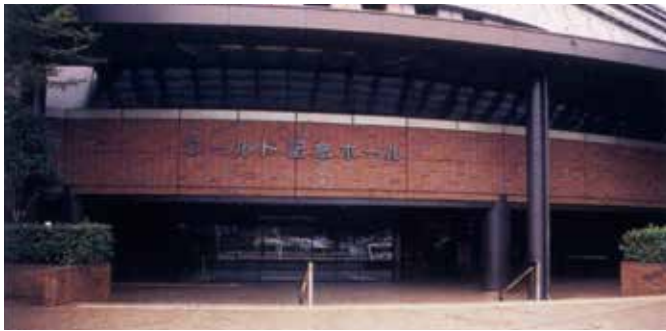
正面玄関 Main entrance
