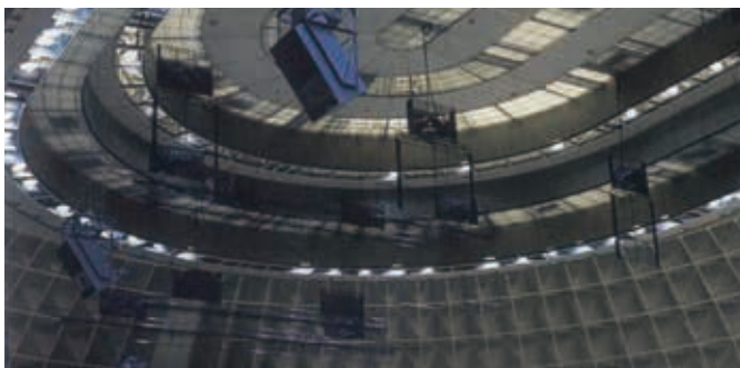
南側バトン Battens on south side
